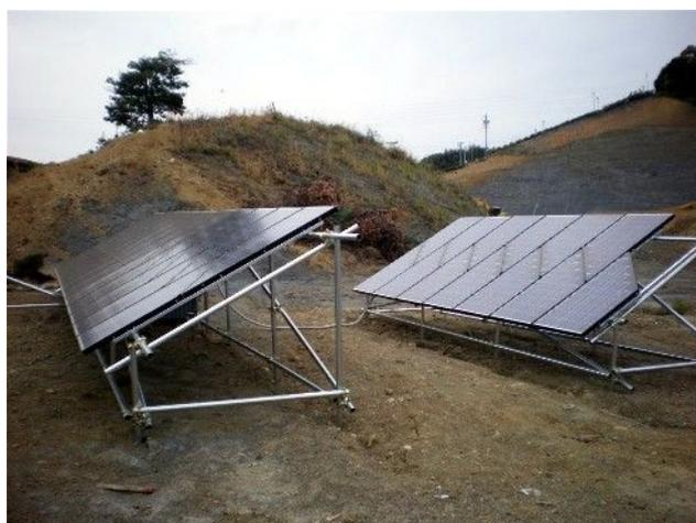
静岡県牧之原市の砂利採取跡地です。遠方に見えるのが静岡空港の南側斜面です。太陽光発電の設置に適しています。今回試験的に設置した太陽光発電は4kWです。架台・パワーコンディショナー一体構造で地震に強く、コストも安く設置出来ました。1kW当たり25万円（消費税別）で設置が可能であることが試算されます。発電した電力は地主の住宅で利用され、余剰電力は中部電力に売電されています。また、この地主により、太陽光発電設置者を募集しています。
