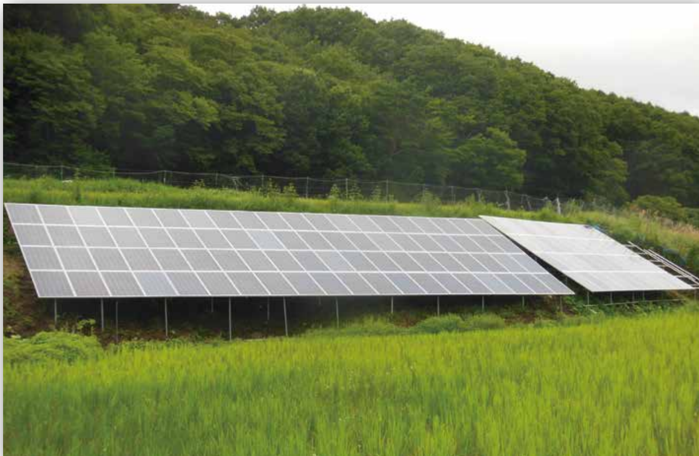
増富太陽光発電所 63 kW 農地の土手(地目原野)にパネルを設置しています。
